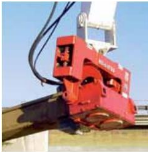
Рис.4. Закрепление вибропогружателя на шпунтине
