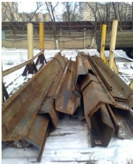
Рис.2. Складирование шпунта
